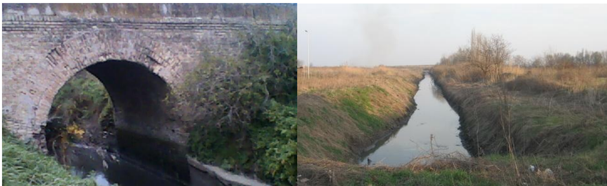
Слика 6. Приказ канала отпадних вода (извор: ЈКП „Чистоћа и зеленило“)
