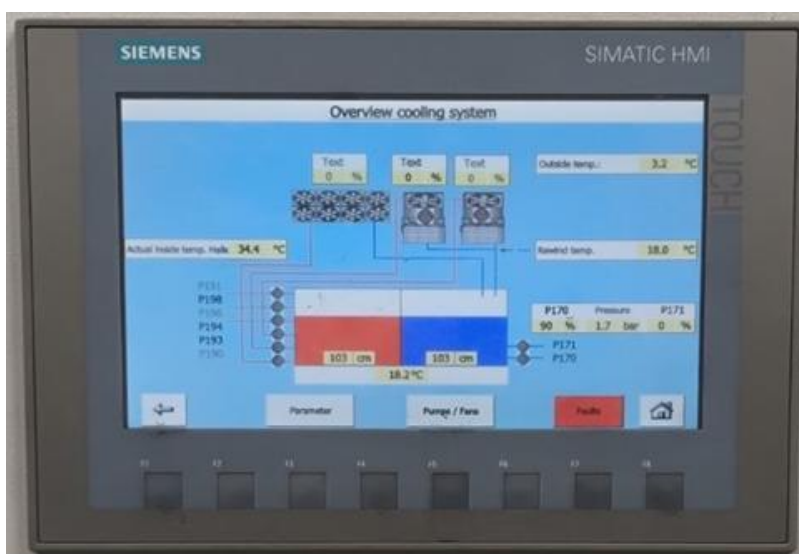
Слика 3: SIMENS HMI дисплеј за праћење параметара температуре на резервоару за техничку воду
