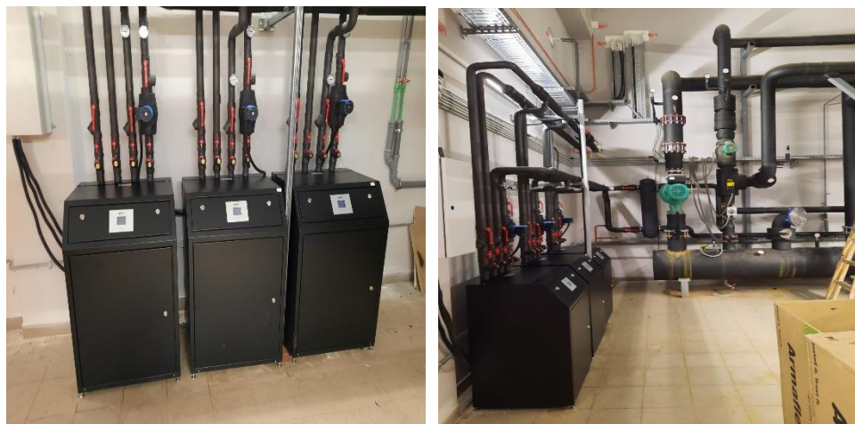
Слика 10: Инсталиране топлотне пумпе у котларници ARTEL HP-90H Оригиналне фотографије
