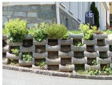
Sl. 45 Potporni zid od prefabrikovanih elemenata
