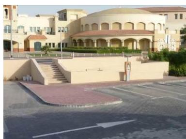
Sl. 41 Potporni zidovi i rampa kao dvostruki element
