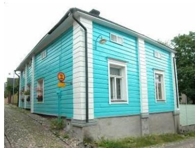
Sl. 53 Pilaster na drvenoj kući
