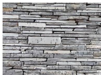
Sl. 37 Zid od tesanog pločastog kamena
