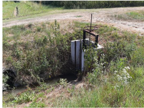
Слика 90. Устава за доводни канал рибњака (Фото М. Урошевић)
