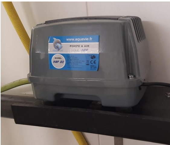
Слика 153. Пумпе за аерацију воде у базенима (Фото М. Урошевић)
