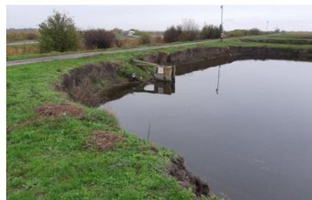
Слика 88. Насип окруњен услед ерозије (Фото М. Урошевић)
