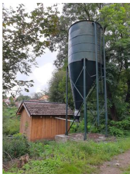
Слика 159. Силос за аутоматски систем исхране риба (Фото М. Урошевић)
