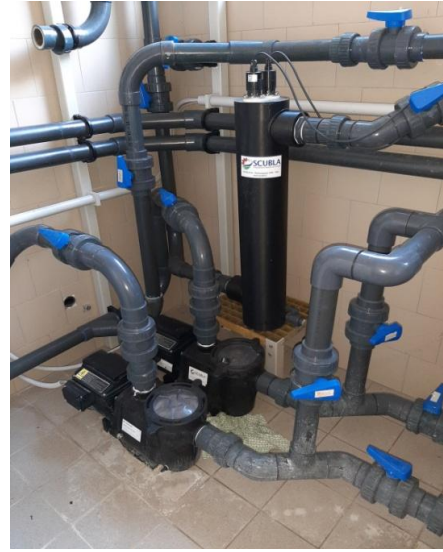
Слика 152. Пумпе за потискивање воде у систему (Фото М. Урошевић)
