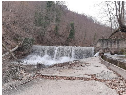
Слика 94. Брана са постављеним водозахватом за пастрмски рибњак (Фото М. Урошевић)
