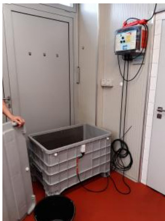
Слика 183. Кадица за омамљивање риба електричном струјом (Фото М. Урошевић)
