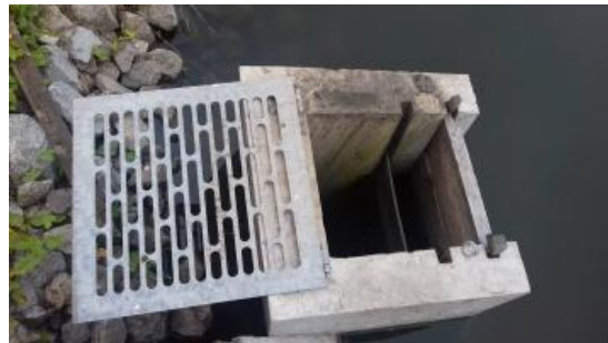
Слика 92. Поклопац грлењака (Фото М. Урошевић)
