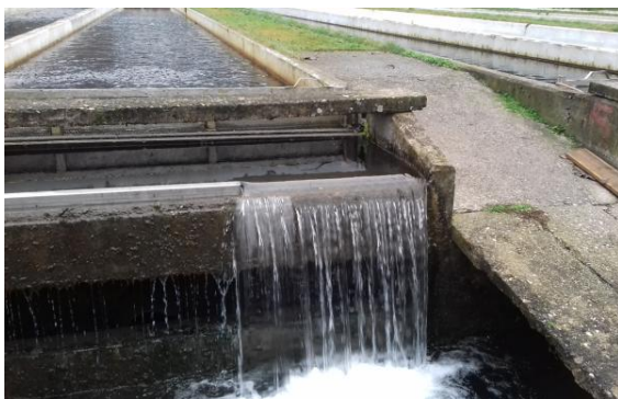
Слика 99. Преливање воде које омогућава аерацију (Фото М. Урошевић)
