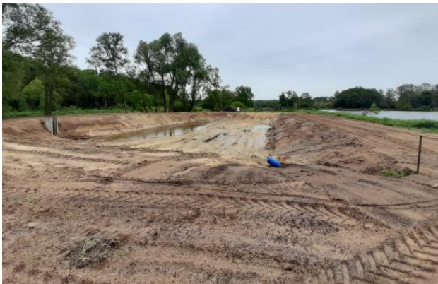
Слика 85. Изградња шаранског рибњака са постављеном уставом и цевима (Фото М. Урошевић)
