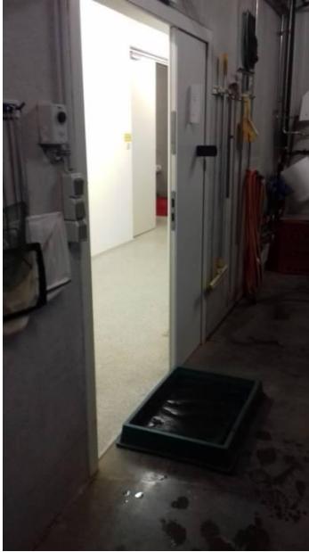
Слика 172. Дезобаријера на улазу у објекат РАС (Фото М. Урошевић)
