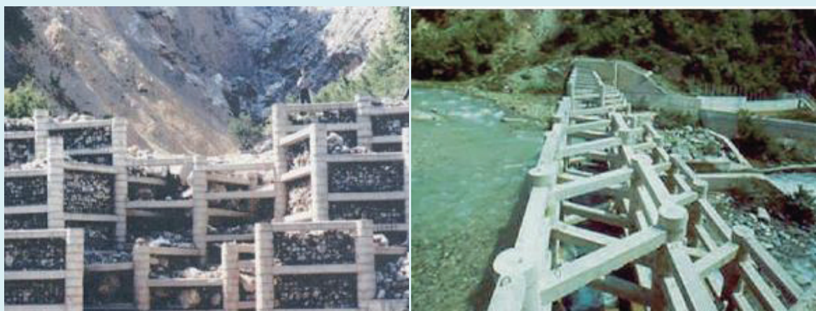
Слика 7 а и б. Решеткасте преграде Херхеулидзеа (фото: проф. Иван Блинков)
