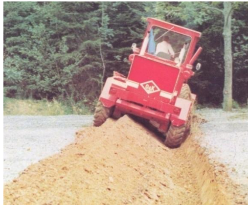
Slika 2.28. Grejder u radu pri kopanju kanala
