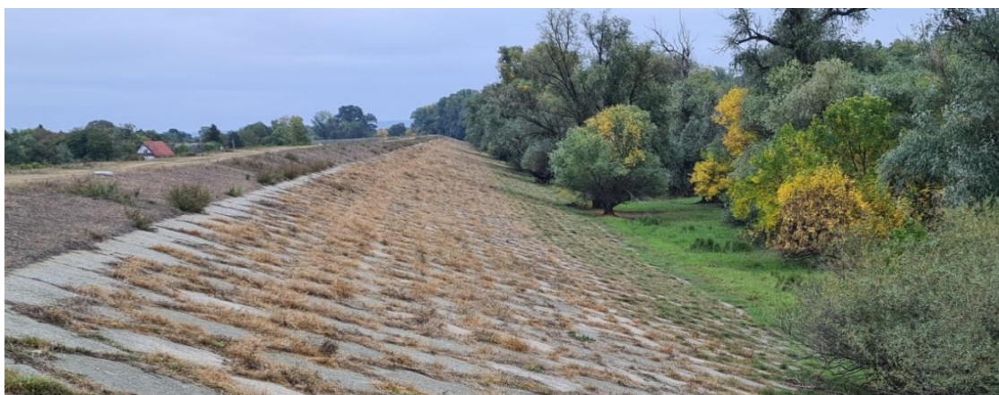
Слика 68. Одржавање облога насипа хемијским третманом (ориг. фото: Попов, М.)
