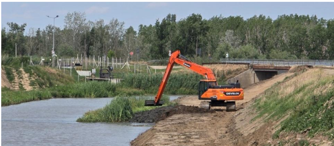
Слика 66. Механичко чишћење канала (ориг. фото: Попов, М.)
