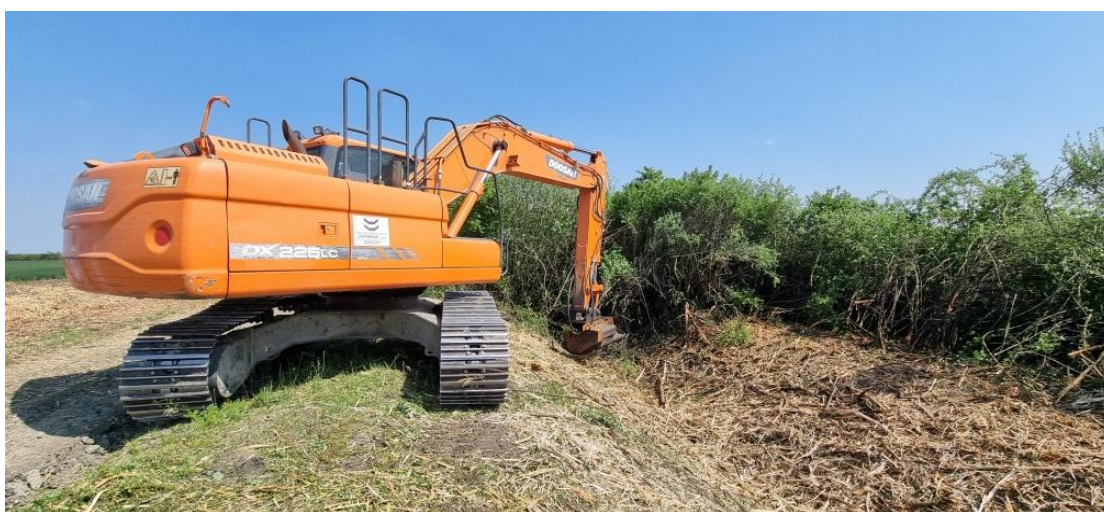
Слика 67. Тарупирање канала (ориг. фото: Попов, М.)
