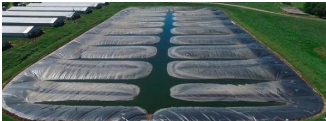
Слика 23. Лагуна на свињарској фарми обложена пластичном фолијом (преузето са https://www.shutterstock.com уз право коришћења)
