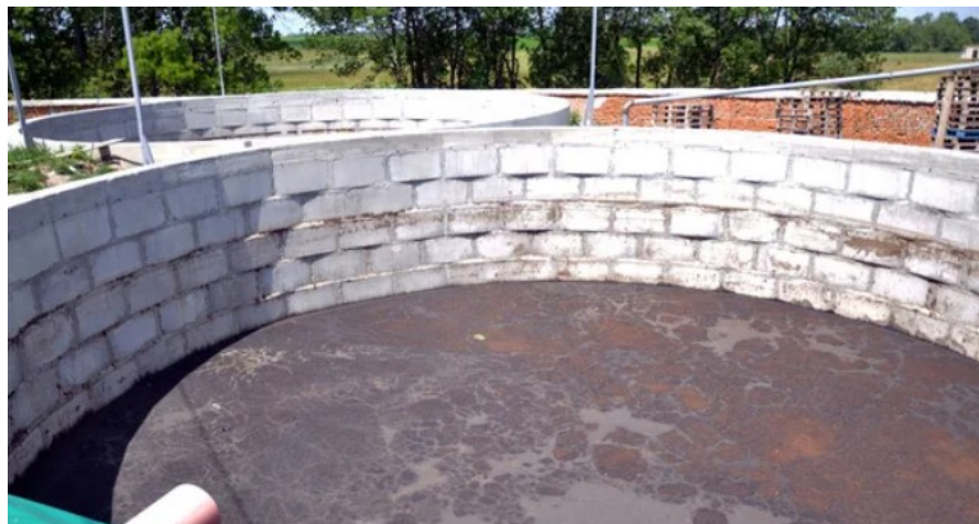
Слика 21. – Бетонски надземни базен за стајњак (преузето са https://www.shutterstock.com уз право коришћења)
