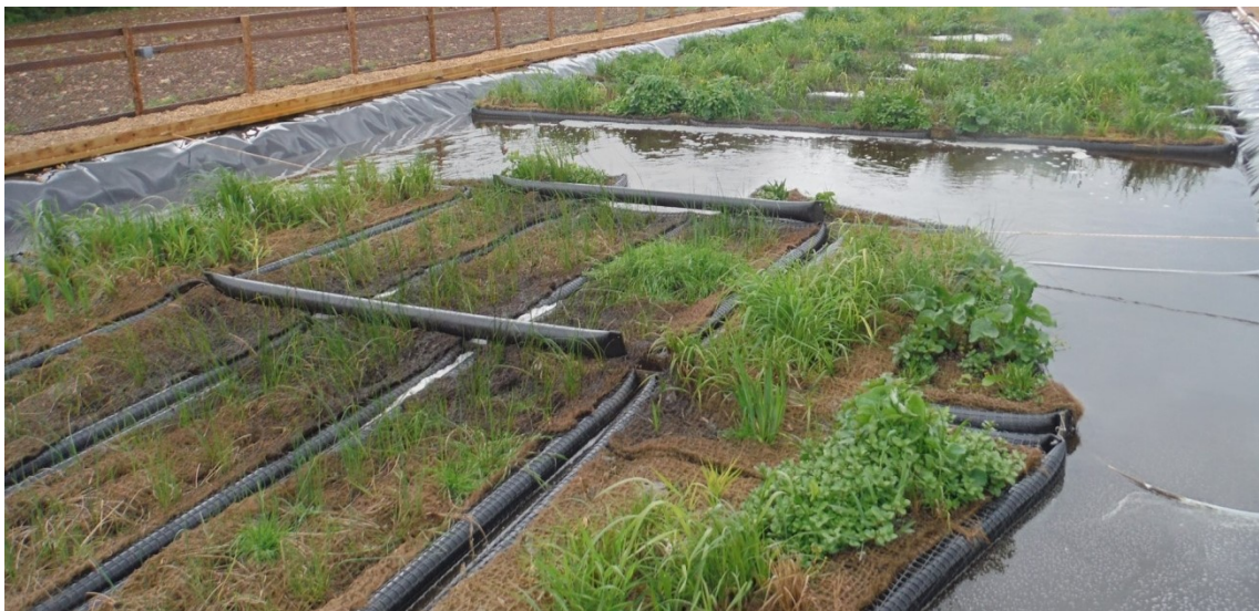
Слика 19. Изглед конструисане мочваре која служи за пречишћавање воде (преузето са https://www.shutterstock.com уз право коришћења)
